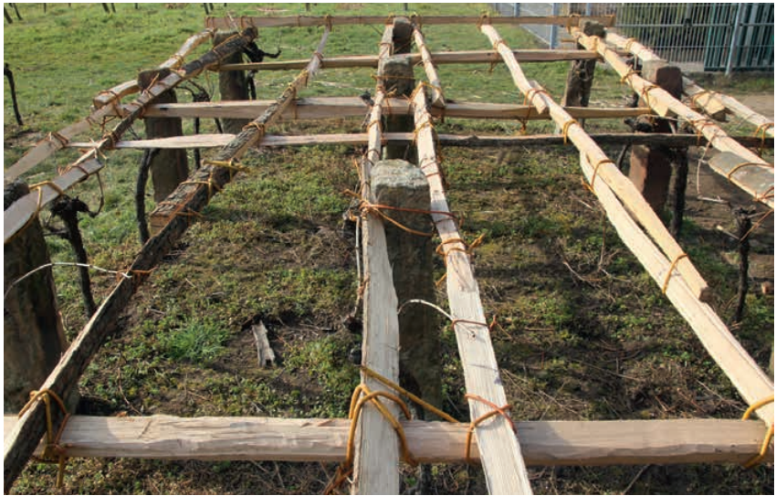
Abb. 1 und 2: Erneuerung des Kammertbaus im Johannitergarten.
